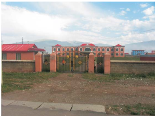
三江源站站区
